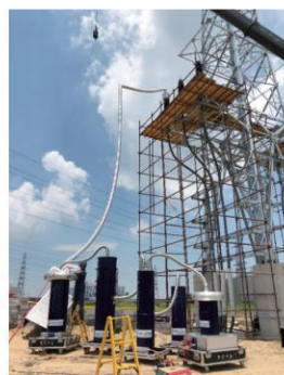
检测现场图片
