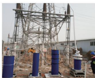
检测现场图片
