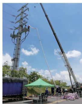
检测现场图片
